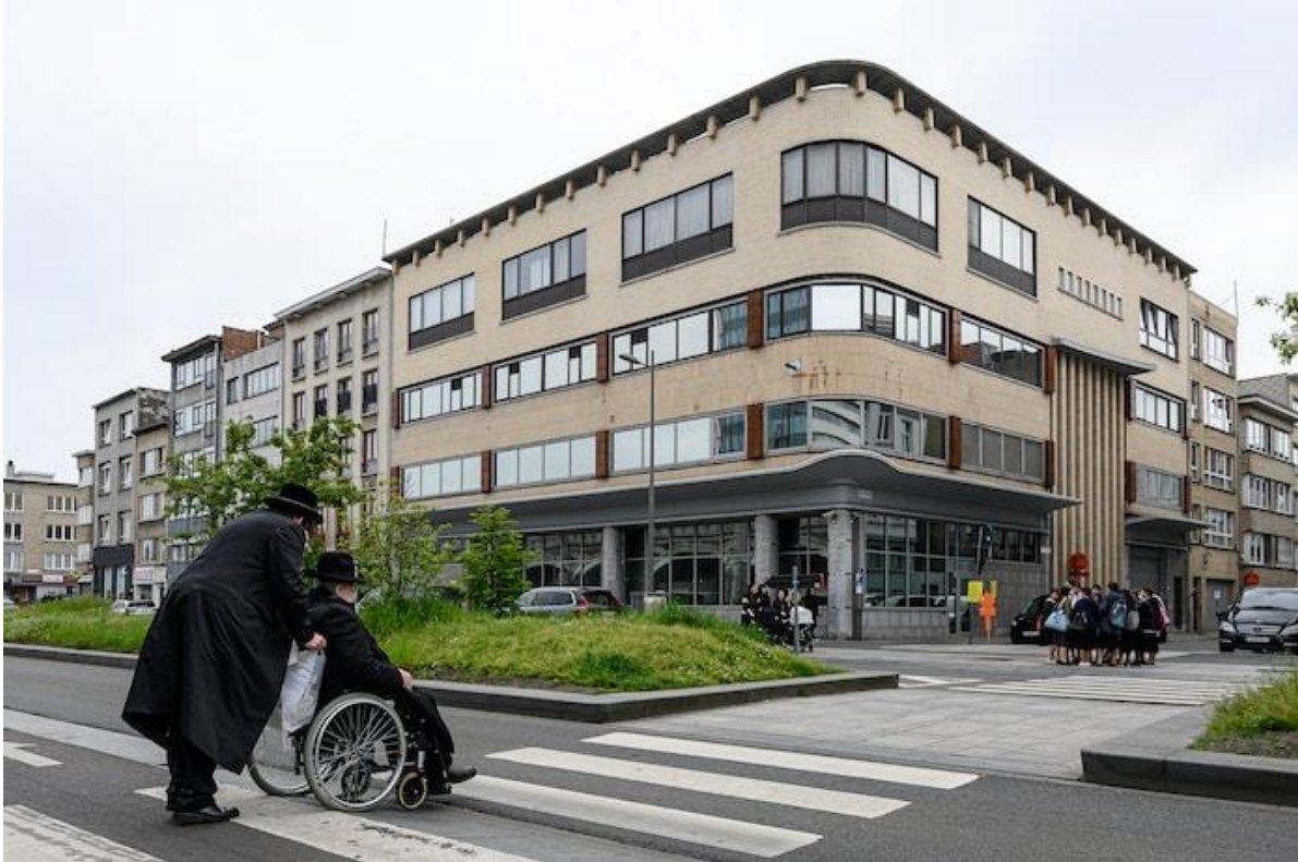
Het fabrieksgebouw van de voormalige goudraffinaderij Value Trading zal gesloopt worden. Er komt een volledige nieuwbouw in de plaats. © Klaas De Scheider
