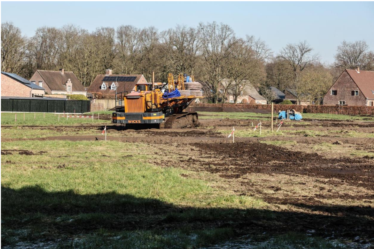
Grondwerken kondigen n zes jaar van administratieve hinderpalen de echte start aan van Park D'Audaen. © Koen Fasseur
