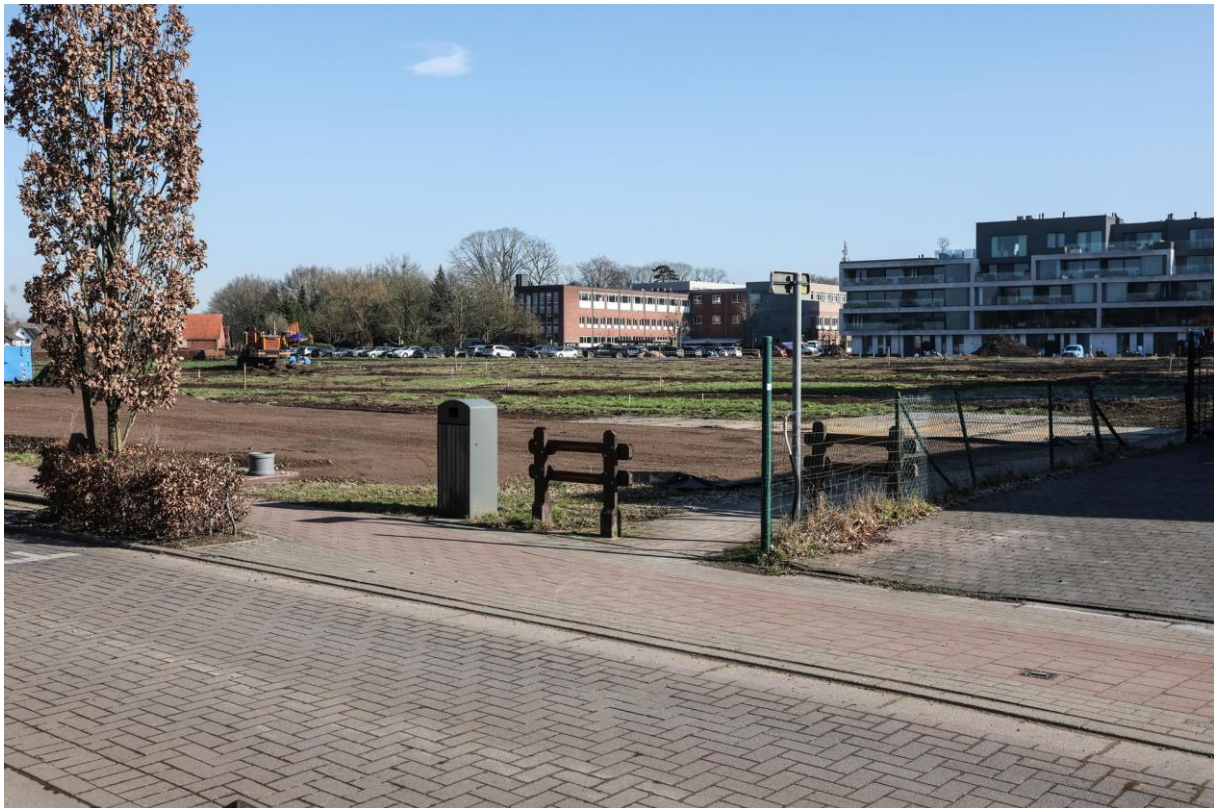
Aan de Moerstraat in 's-Gravenwezel zijn de grondwerken voor residentie Park D'Audaen gestart. © Koen Fasseur
