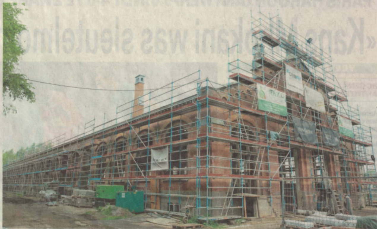
De douaneloods in Essen wordt in 2020 veroverd door robots. Foto Laenen
