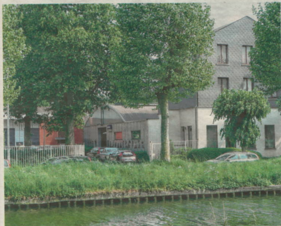
De familie Postiaux verhuist haar Volvo-servicecenter dit najaar naar Sint-Job. De auto-werkplaats in de Heikantstraat maakt plaats voor een woenerf. FOTO JAN AUMAN
