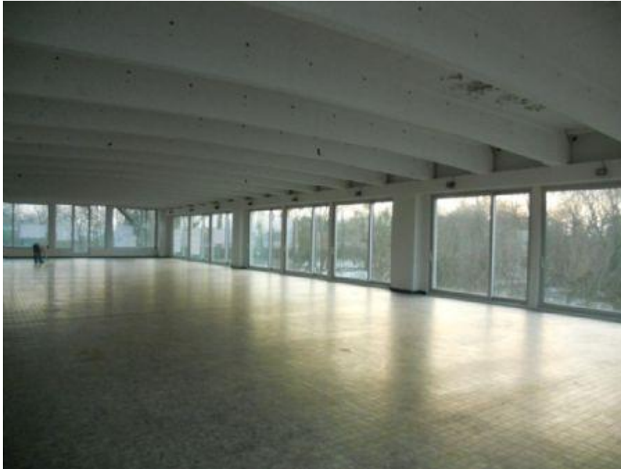
De grote fabriekszalen kennen een zuivere balkenstructuur (Foto: mertens-architecten).
